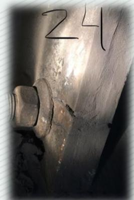
Осмотр показал видимые дефекты тоннеля левого: имеются трещины в основании чугунного кольца, в своде, деформации швов, а также отрыв маячка на границе чугунных и бетонных колец
